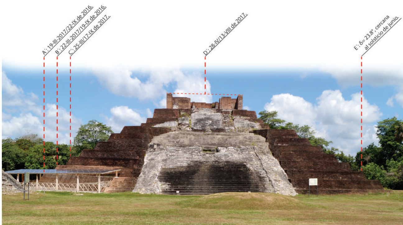
Figura 6: Templo I visto desde la Estación 1, en el Basamento Frontal Oeste. Se nota cómo no conocemos el Paramento Superior y la Crestería del templo.
