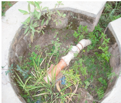
Fig.4 Pozo ubicado atrás del L-2
